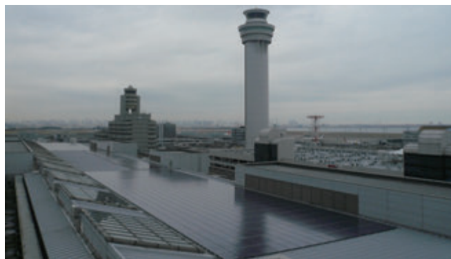
太陽光発電システム導入
